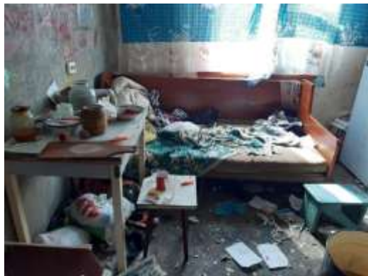
антисанитарное состояние жилья
